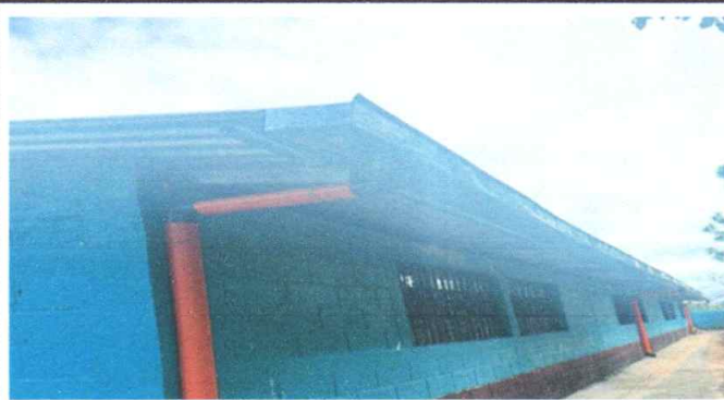
Foto 2: Canales y bajadas de agua pluvial instalados
