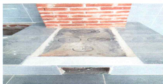
Foto 5: Plancha de estufa rural colocada
