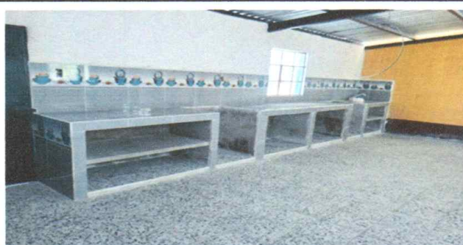
Foto 3: Mesas de concreto en la cocina terminadas
