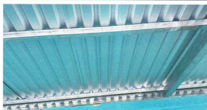
Foto 2: Estructura de soporte de metal instalado
