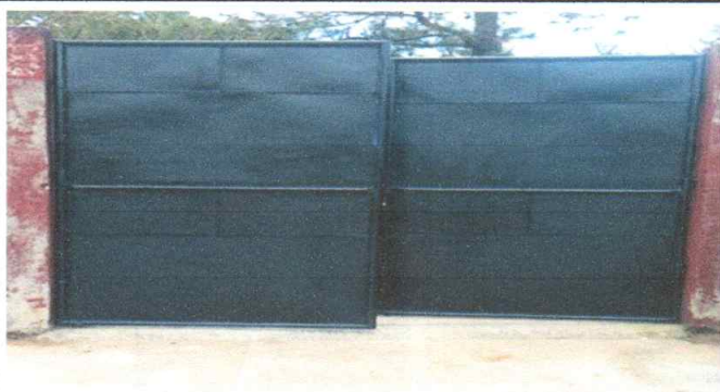
Foto 4: Portones reparados y pintados
