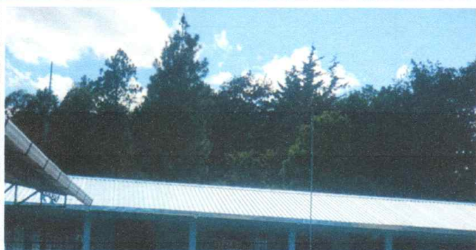
Foto 1: Cubierta de lámina instalada
