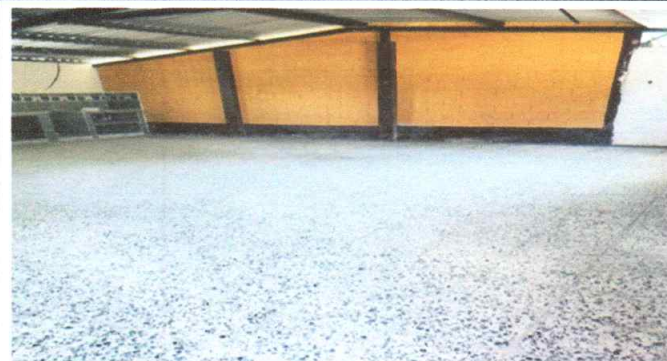
Foto 3: Piso granito colocado
