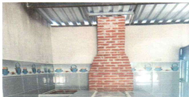
Foto 6: Chimenea de ladrillo terminada
